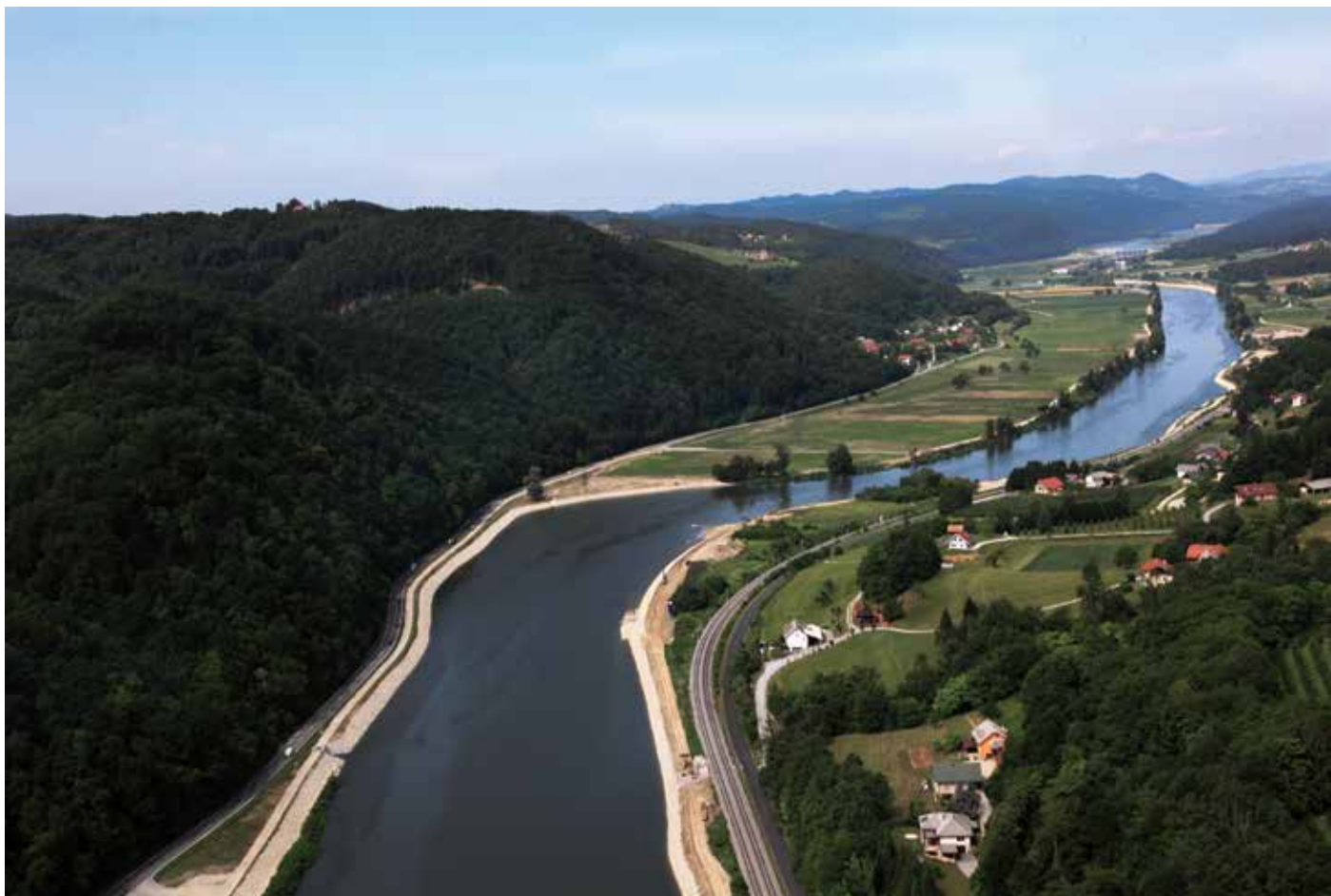
Akumulacijski bazen reke Save; foto: Arhiv HESS
