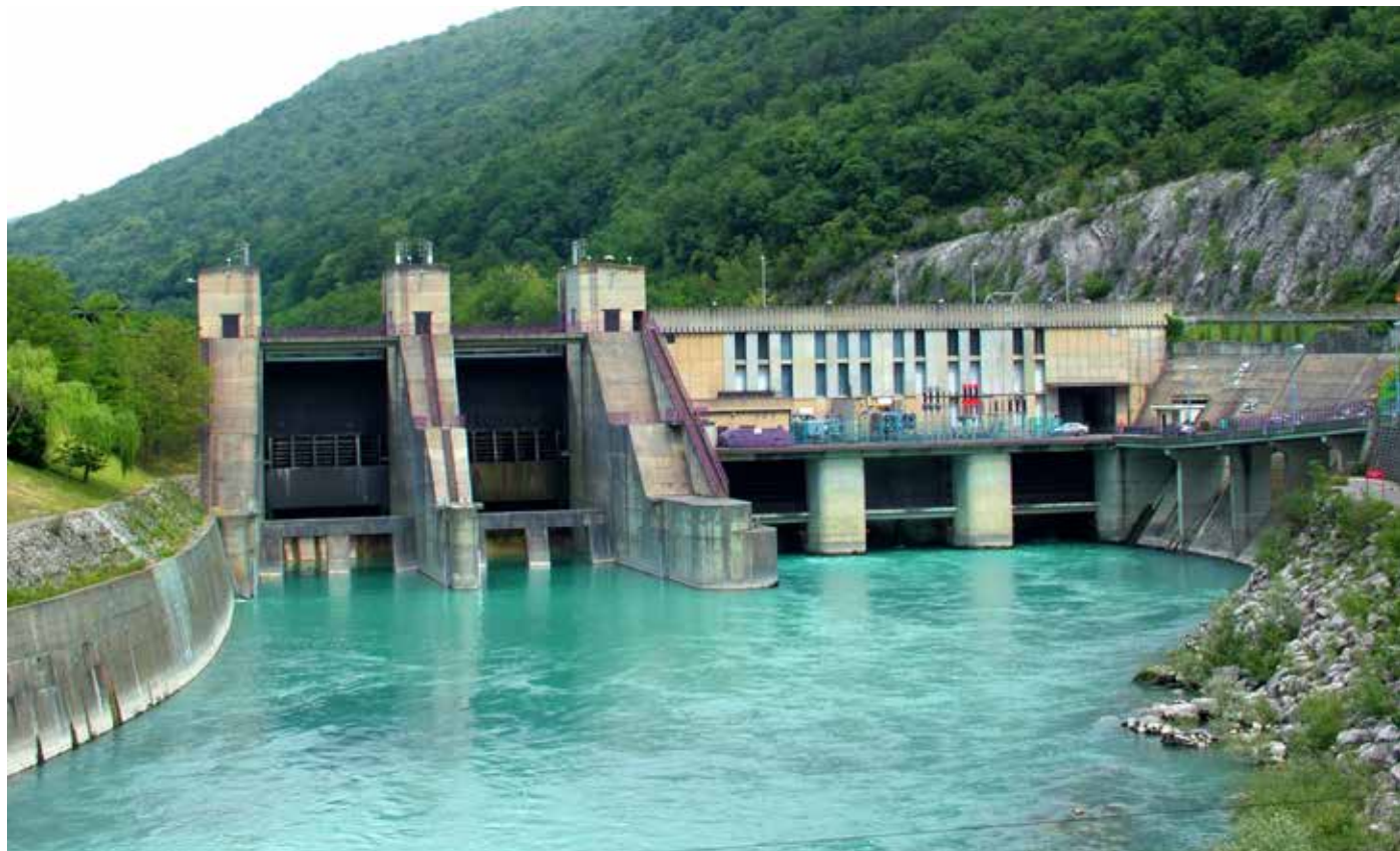
V situacijah, ko prenosno omrežje ni v polni funkcionalnosti, imajo pomembno vlogo sistemske hidroelektrarne na Soči, saj morajo zagotavljati ustrezne napetosti v prenosnem omrežju. Na fotografiji je zadnja v verigi HE na reki Soči - HE Solkan; foto: Arhiv SENG
