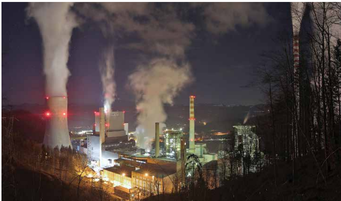
Termoelektrarna Šoštanj; foto: Arhiv TEŠ
