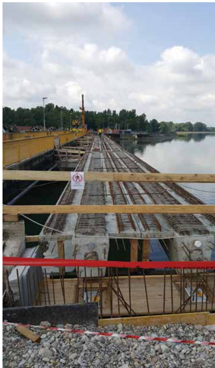
Jez Markovci z delno postavljenim nadomestnim cestiščem. Foto: Arhiv DEM
