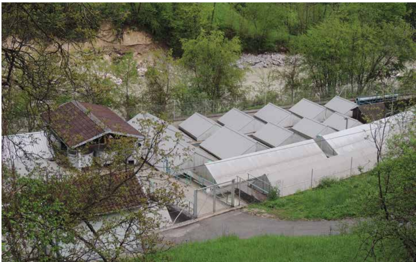
Mala HE Tolmin je zgled zavezanosti Soških elektrarn k trajnostnemu sonaravnemu gospodarjenju z vodami. Med gradnjo elektrarne so sodelovali z Ribiško družino Tolmin in zraven zgradili še ribogojnico, ki prispeva k ohranjanju endemične soške postrvi. Foto: Arhiv SENG
