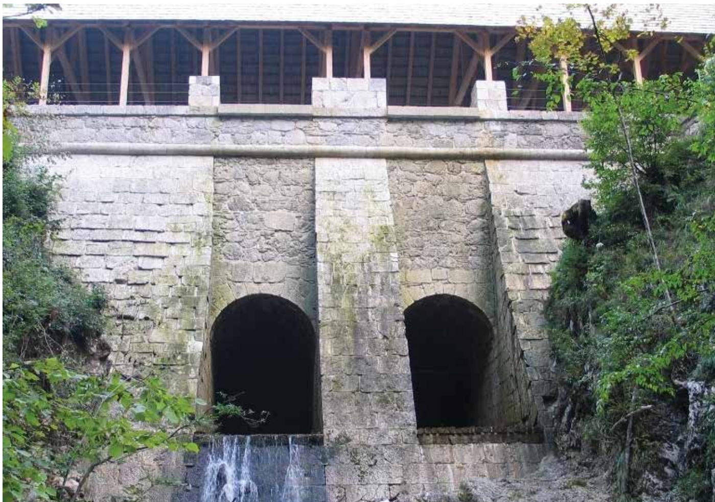
Kanomeljske klavže na vodotoku Klavžarica so bile zgrajene pred dobrima dvema stoletjema in so služile za transport lesa v dolino. Za klavžami akumulirana voda sedaj služi za proizvodnjo elektrike v mali HE Klavžarica. Foto: Arhiv SENG
