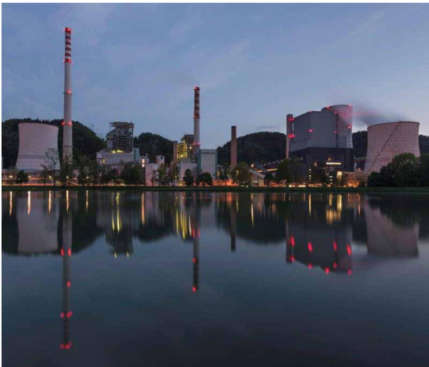
Termoelektrarna Šoštanj; foto: Goran Vadlja Kamenjašević
