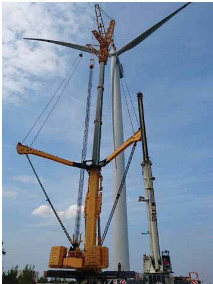
Montaža vetrnice; foto: Arhiv HSE Invest
