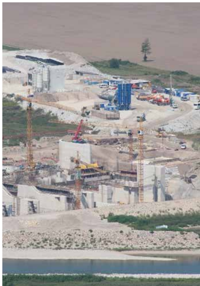
Izvajanje del na gradbišču HE Brežice; foto: Arhiv HESS
