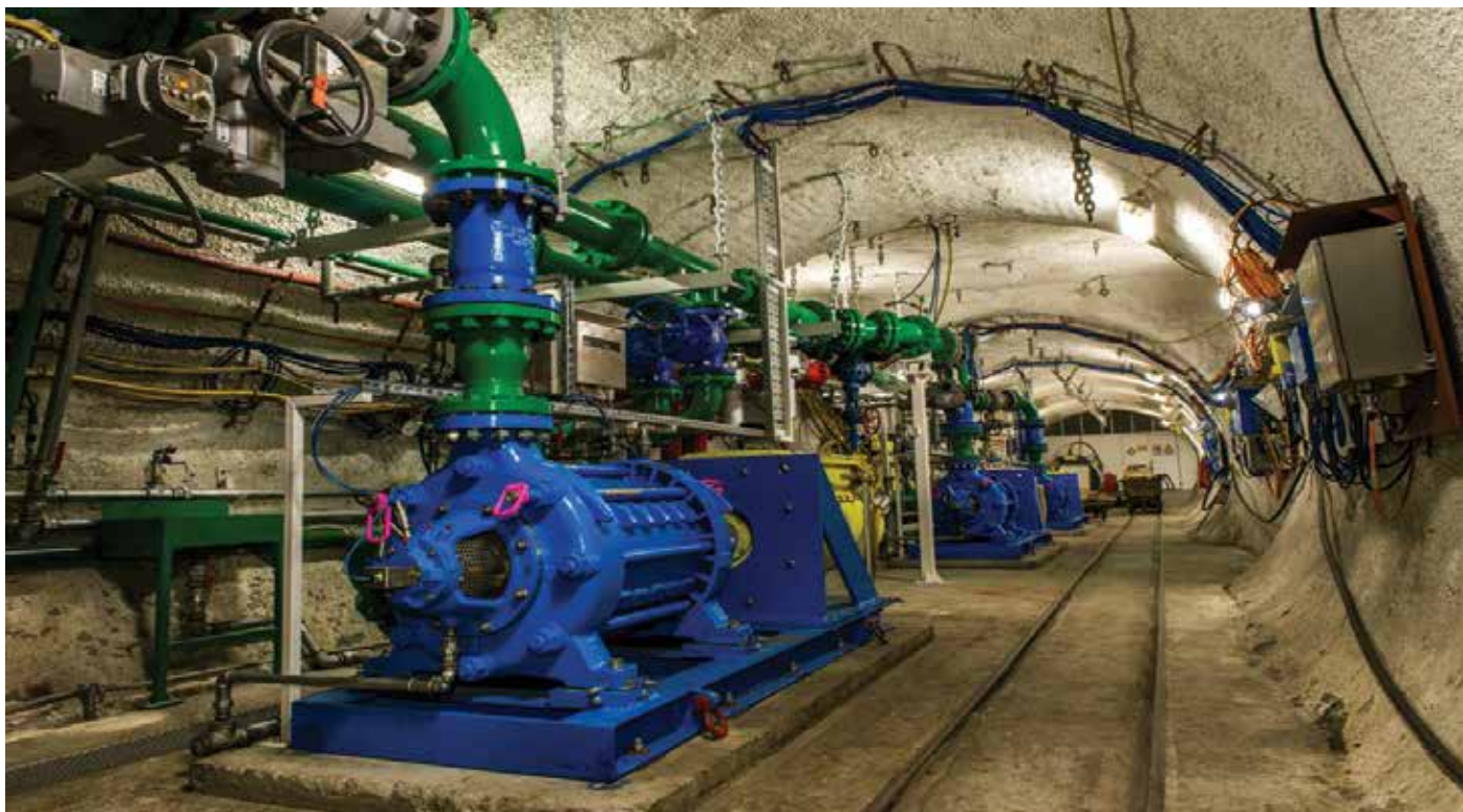
Novo glavno jamsko črpališče na k. -41,5; foto: Danijel Šibanc
