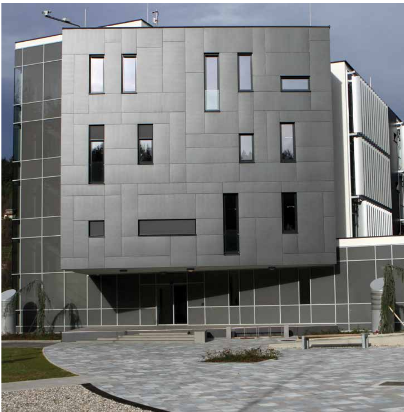
Poslovna stavba HSE Investa; foto: Arhiv HSE Invest
