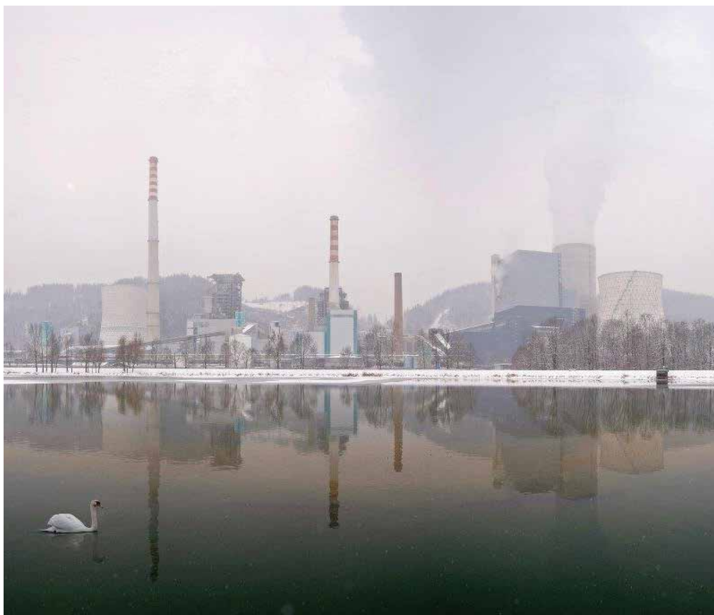
Termoelektrarna Šoštanj; foto: Arhiv TEŠ
