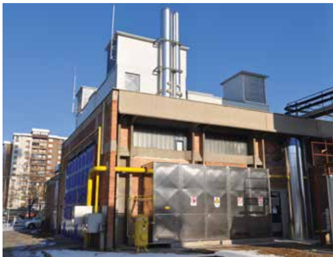
Kotlovnica Planina Kranj; foto: Arhiv HSE
