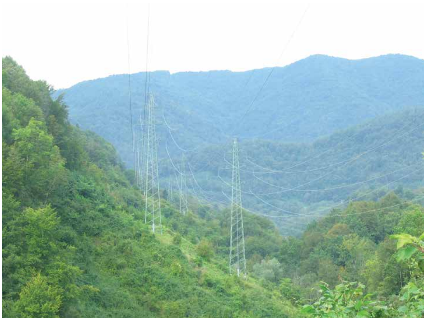
Trasa dvojnega dvosistemskega 110 kV daljnovoda; foto: Arhiv SENG
