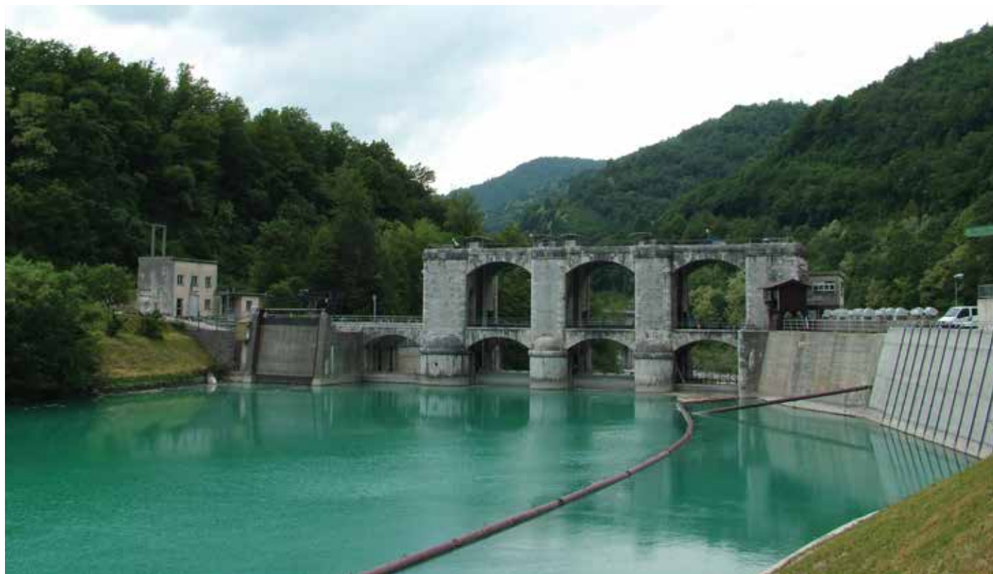
Pregrada Ajba je betonske izvedbe s tremi pretočnimi polji z dvema prelivnima poljema in vtokom v elektrarno. Akumulacijo s HE Plave I povezuje 6,5 km dolg dovodni kanal, s HE Plave II pa 5,6 km dolg tlačni tunel. Akumulacija služi tudi kot spodnji bazen prve črpalne hidroelektrarne Avče. Foto: Arhiv SENG
