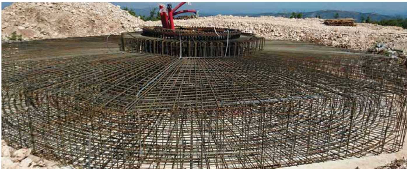
Armatura temelja z vgrajenim košem za montažo stebra vetrnega agregata. Po opaženju bo temelj pripravljen za betoniranje; foto: Arhiv HSE Invest
