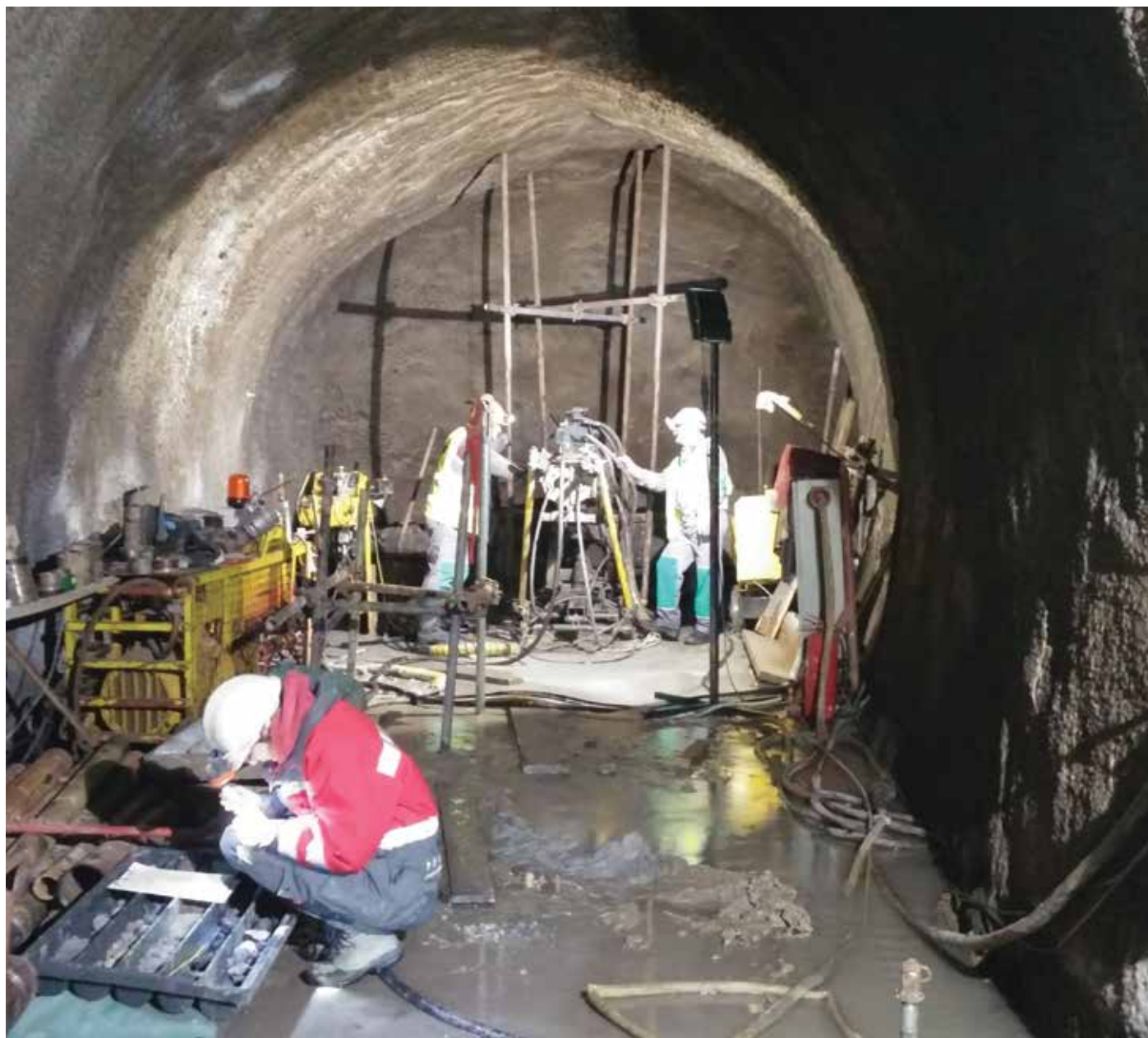
Vrtalna dela v predoru Karavanke; foto: Tadej Vodušek
