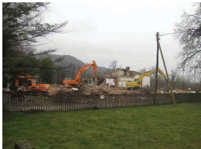
Rušitev klavnice; foto: Arhiv HSE Invest
