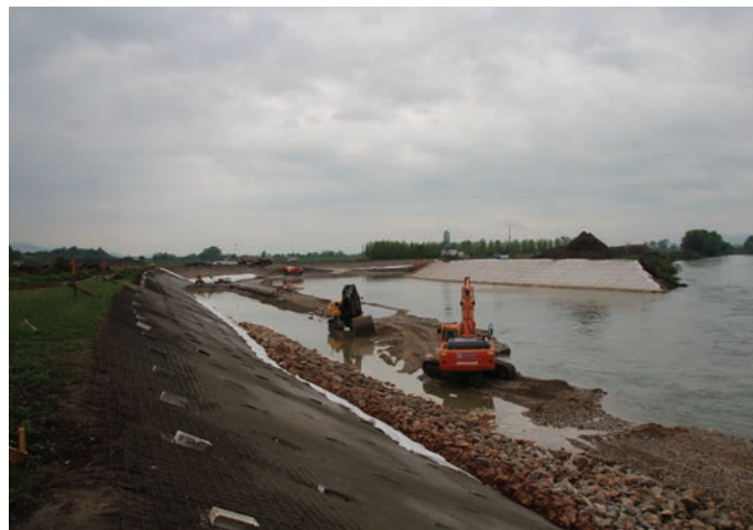
Dela na obtočnem kanalu; foto: Arhiv HSE Invest
