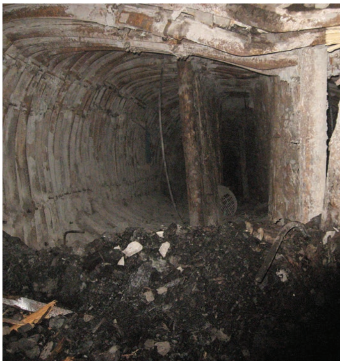
Izdelava pristopnih objektov in etaže CD1; foto: Arhiv PV
