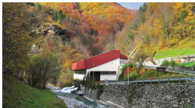
HE Zadlaščica iz leta 1989 je lep primer umeščanja gospodarskega objekta v občutljiv naravni prostor Triglavskega narodnega parka, hkrati je večnamenski objekt, saj zagotavlja pitno vodo za širše območje Tolmina in Mosta na Soči. Arhiv SENG
