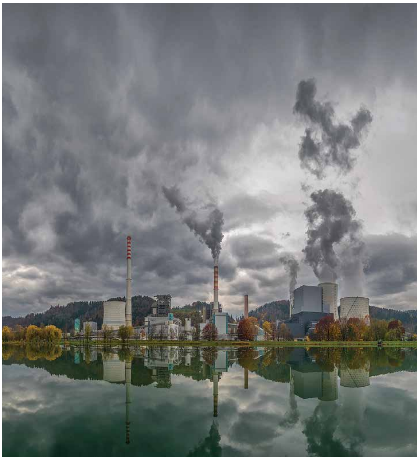
Termoelektrarna Šoštanj; foto: Arhiv TEŠ
