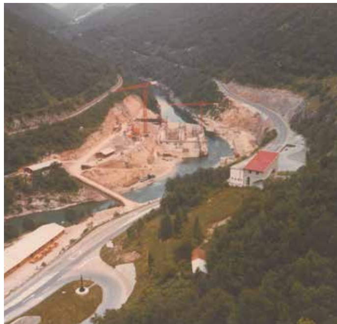
Gradbena jama za hidroelektrarno Solkan okoli leta 1980. HE Solkan je začela obratovati leta 1984. Zasnovana je kot zadnja v verigi hidroelektrarn na Soči in je zato prevzela vlogo izravnalne elektrarne, saj izrablja del koristnega padca od elektrarne Plave do meje z Italijo. Je tipična pretočna elektrarna s tremi navpičnimi kaplanovimi turbinami in tremi trifaznimi sinhronimi generatorji. Foto: Arhiv SENG
