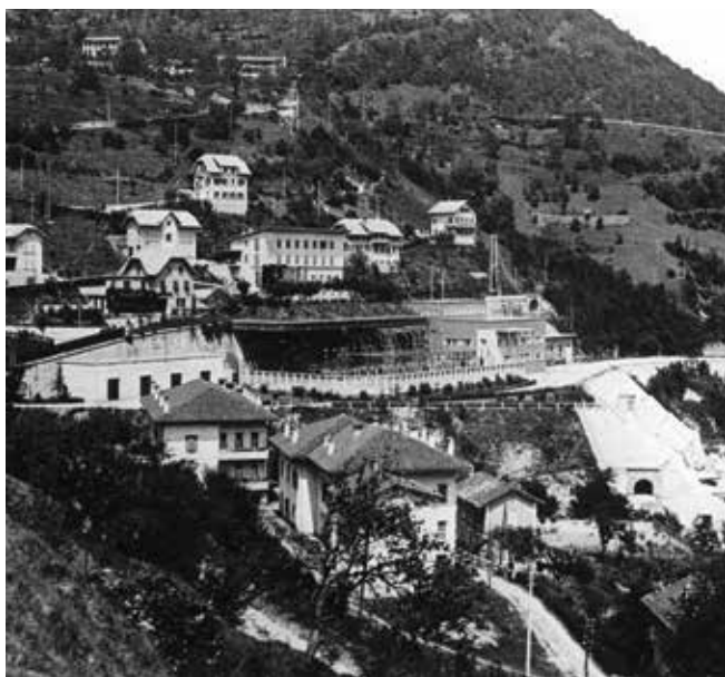
1939 - Elektrarniško naselje v Doblarju okrog leta 1940. Prva hidroelektrarna na Soči je začela obratovati leta 1939, to je HE Doblar I, leto za njo pa še HE Plave I. Foto: Arhiv SENG
