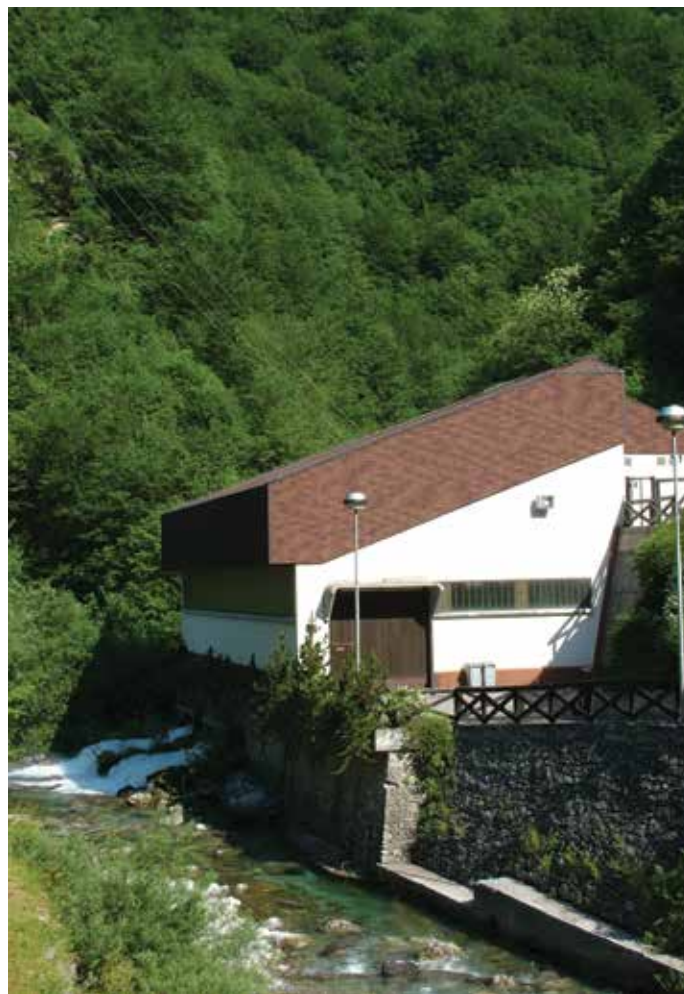
Hidroelektrarna Zadlaščica; foto: Arhiv SENG
