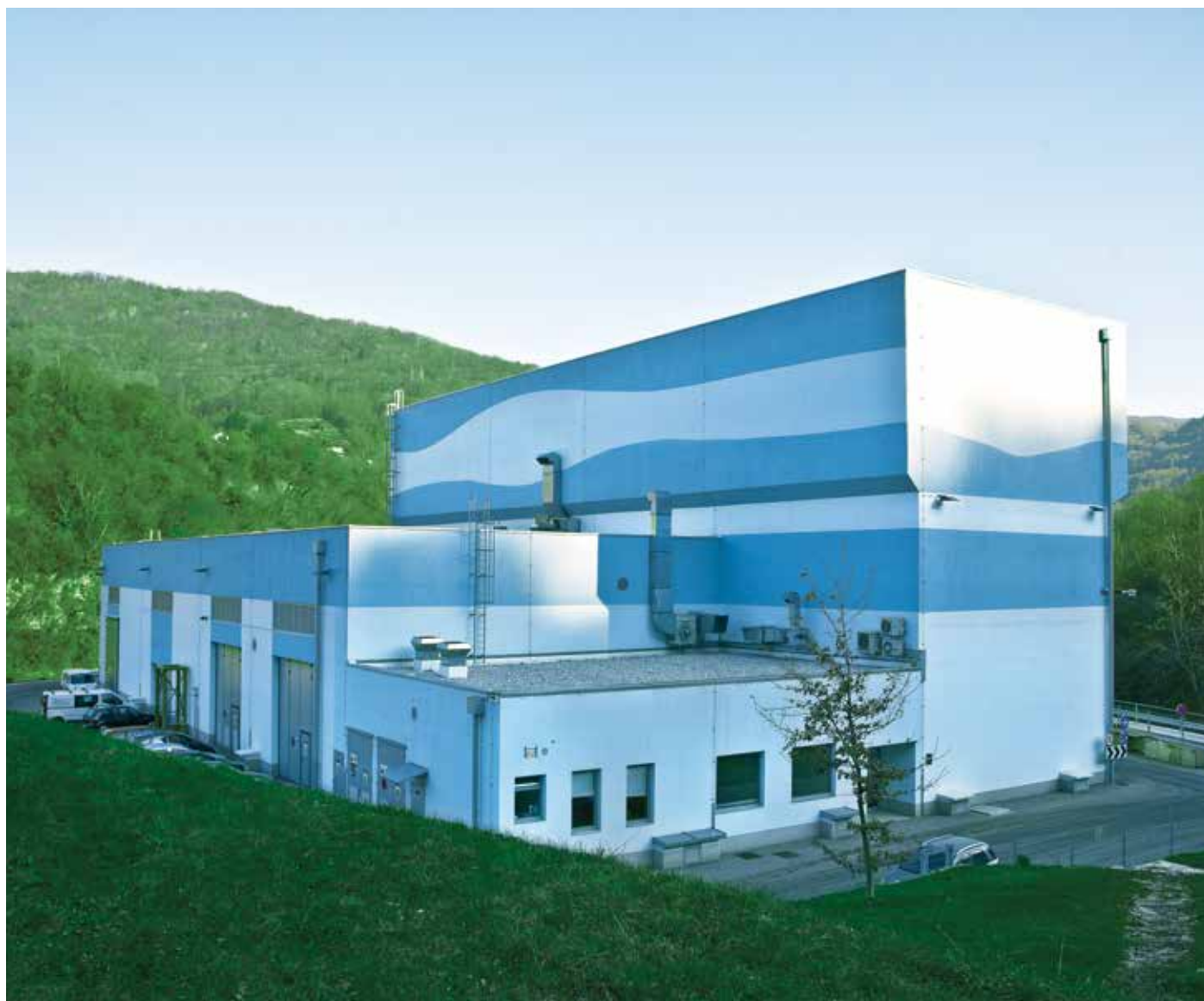
Strojnica črpalne hidroelektrarne Avče; foto: Arhiv SENG
