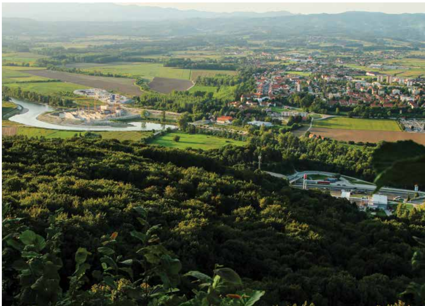
Pogled na gradbišče HE Brežice; foto: Arhiv HESS
