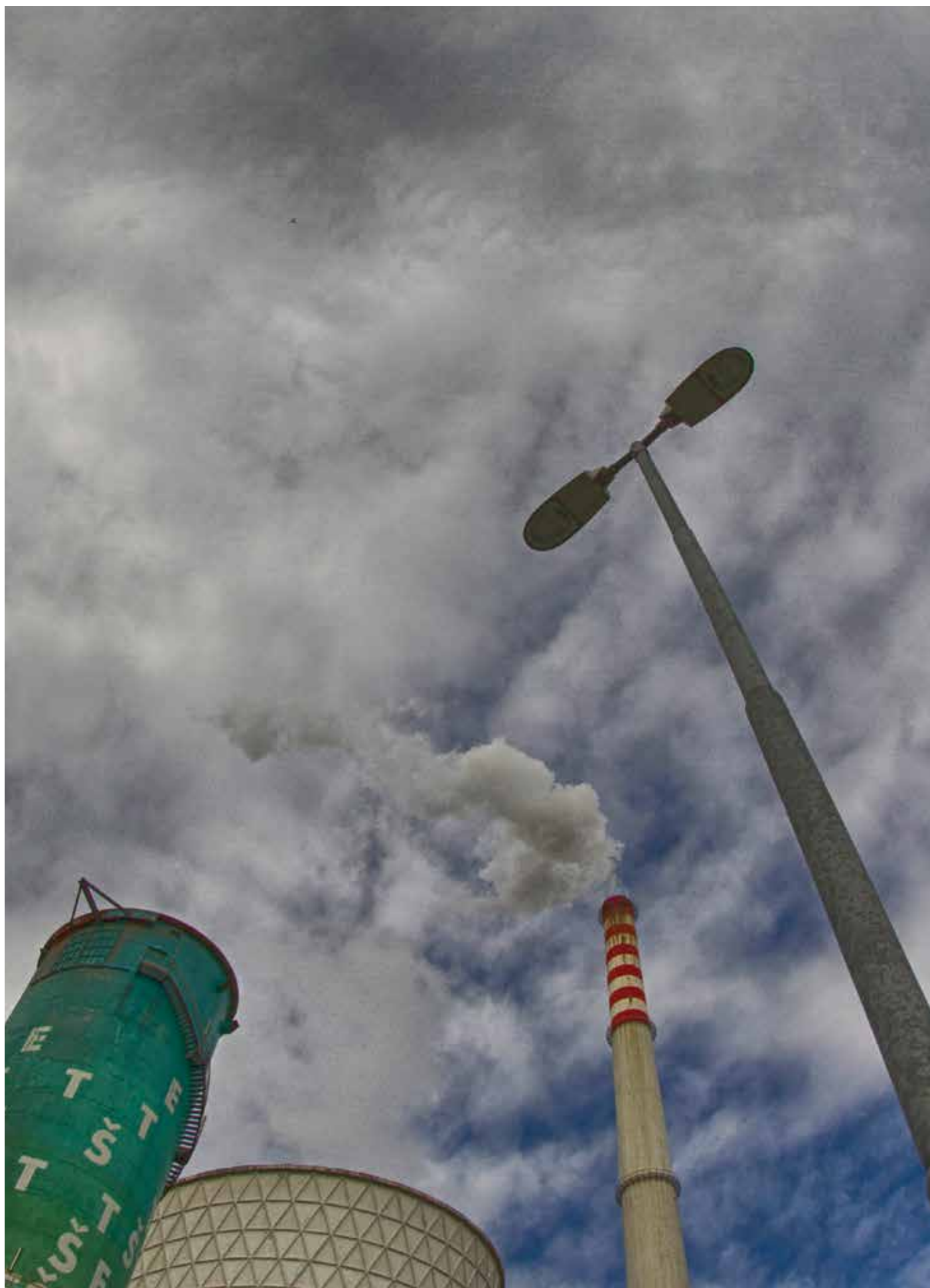
Termoelektrarna Šoštanj; foto: Arhiv TEŠ
