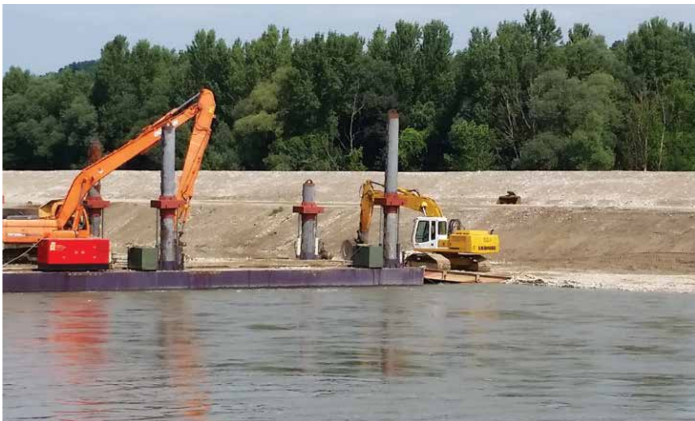
Intenzivna dela v odvodnem kanalu HE Zlatoličje; foto: Arhiv DEM
