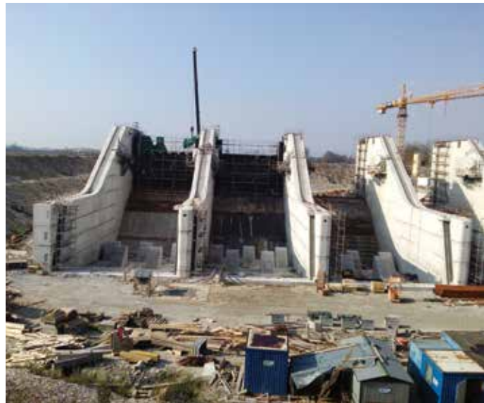
Gradnja energetskega dela HE Brežice; foto: Arhiv HESS
