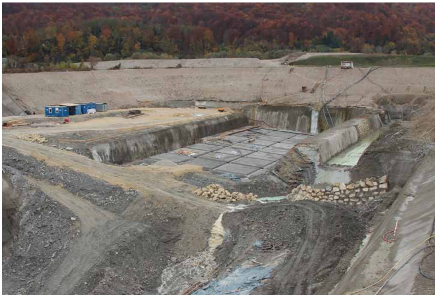
Gradbena jama HE Brežice; foto: Arhiv HESS
