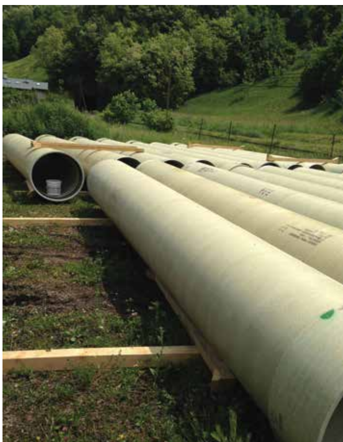
Tlačni cevovod za MHE Kneža bo v celoti poliestrske izvedbe; foto: Arhiv SENG
