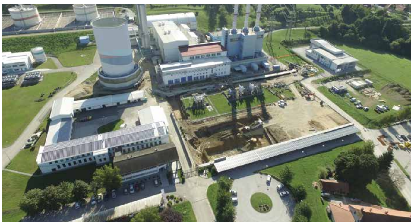
Termoelektrarna Brestanica - območje gradnje novega plinskega bloka GT26; foto: Arhiv HSE Invest
