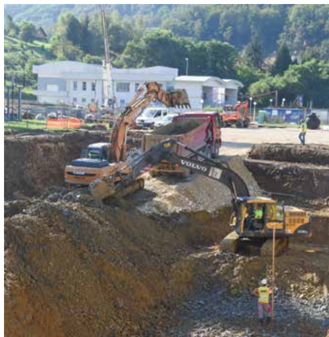
Izvedba gradbene jame glavnega pogonskega objekta GT26; foto: Arhiv HSE Invest
