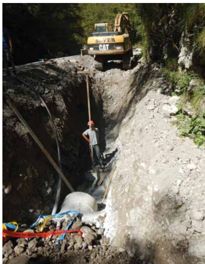
Trenutno poteka na gradbišču MHE Kneža vgradnja tlačnega poliestrskega cevovoda; foto: Arhiv SENG
